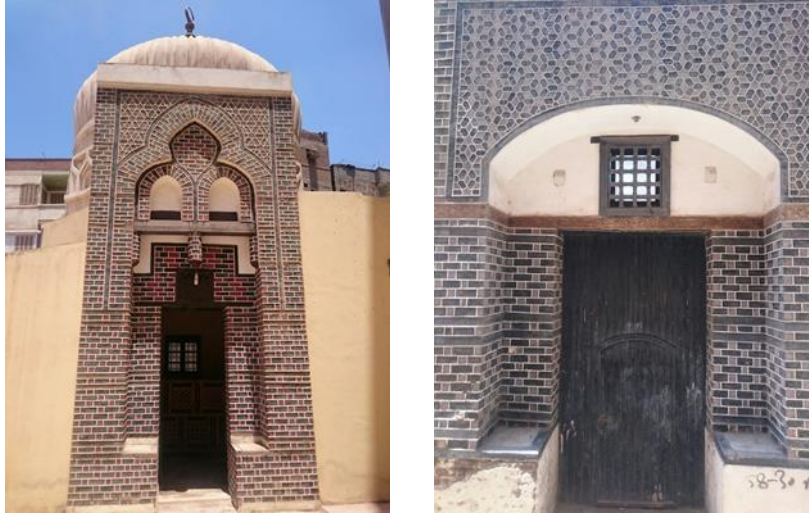
شكل ( 8 ) استخدام الطوب في واجهات المباني الاثرية في مدينة فوه ، المصدر : الباحثين
